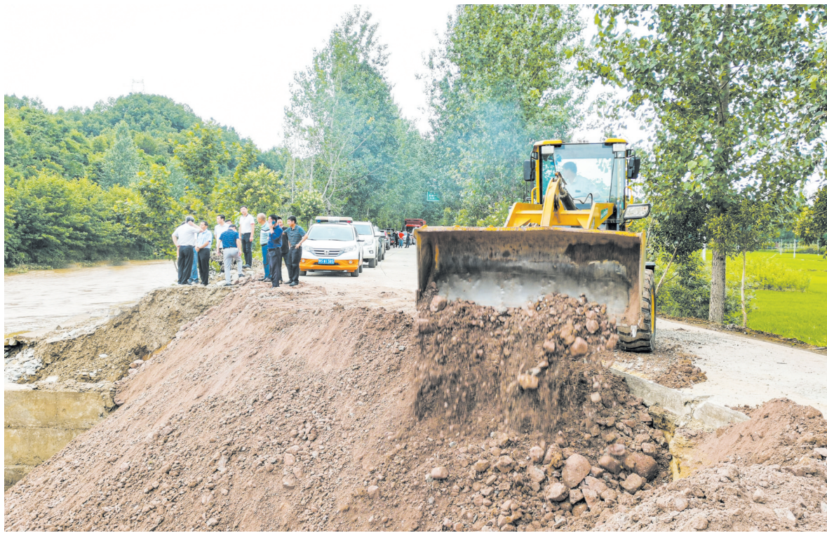
6月27日至28日,强降雨天气导致我市多地出现山体滑坡阻塞交通和水毁道路现象。图为牛程公路随县殷店镇江头店村水毁路段抢修现场。副市长吴超明深入各公路受灾现场查看灾情,指导灾后修复工作。(随州日报全媒体记者李文军摄)
