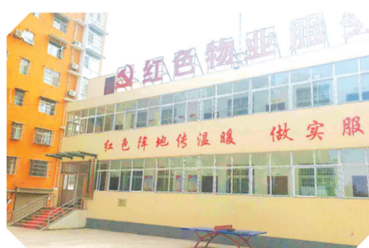
▲ 孔家坡社区科普示范公寓红色物业
