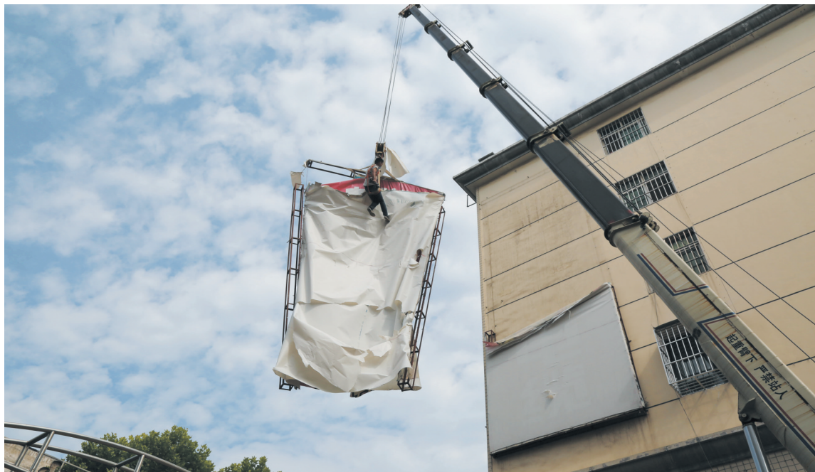
为扎实推进城乡环境综合整治,连日来,市城管执法大队会同曾都区东城办事处,聘请专业人员,对随州城区天生街两边破损旧的店堂招牌、大型墙体广告进行集中拆除,共清除各类户外广告300余处。(随州日报通讯员景少峰摄)
