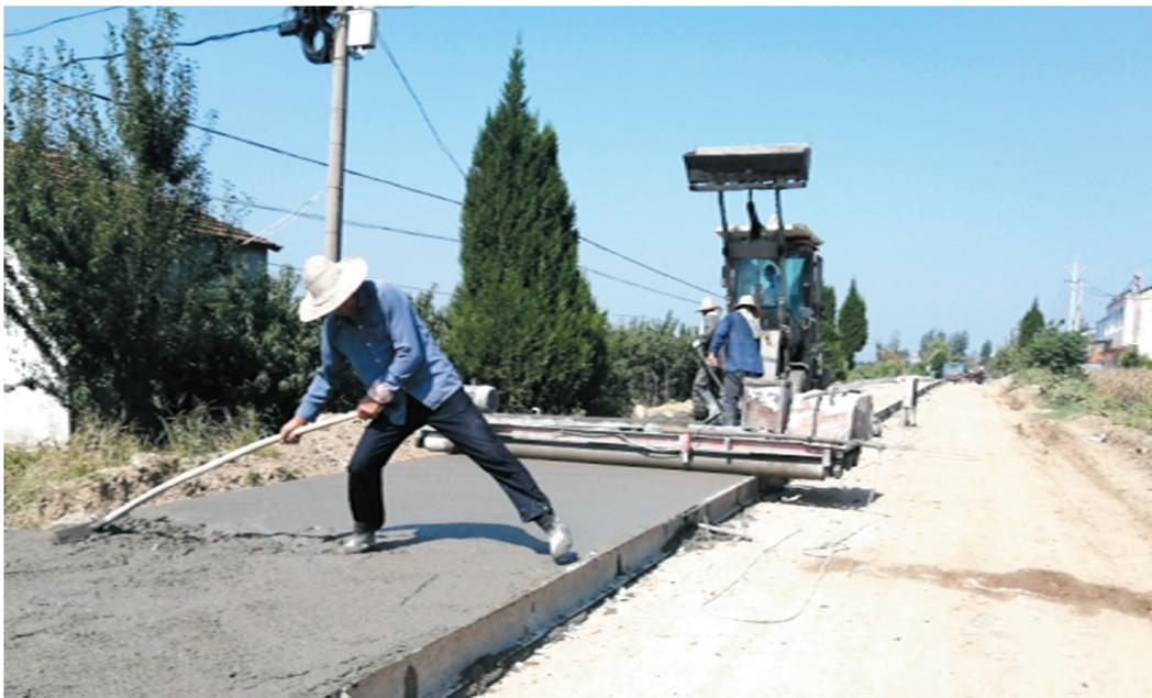
日前,随县尚市镇尚王公路扩改建项目启动,改造路段在原有基础上进行了降坡拉直拓宽,全长约7.5公里,面层为5.5米宽水泥混凝土。据项目施工负责人介绍,项目部在项目两端各架设一个拌合站,由中间向两边开进单幅作业,保障通行不受阻,同时合理安排工人作业时间,加快建设进度。(随州日报通讯员张光耀)
