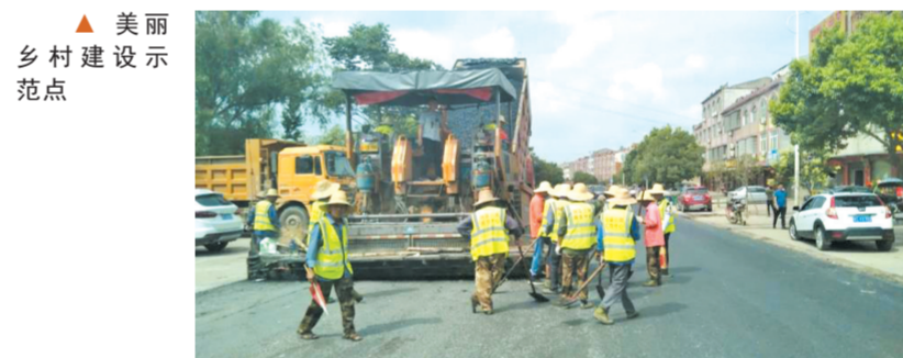
▲ 殷店镇街道路面刷黑工程
