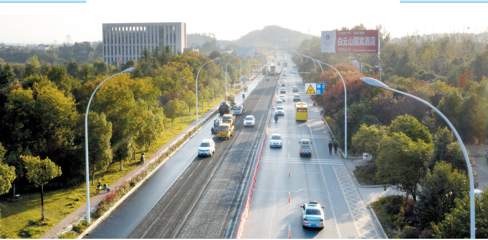
10月26日起,迎宾大道府河大桥(包含府河大桥)至炎帝大道路段开始半封闭改造施工,预计工期30天。有关部门提醒,为避免拥堵,请过往车辆尽量绕行。(随州日报全媒体记者徐斌摄)
