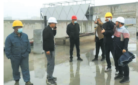
▲ 为加快吾悦广场施工进度,中燃派出设计、施工人员冒雨规划定位部署燃气管位
