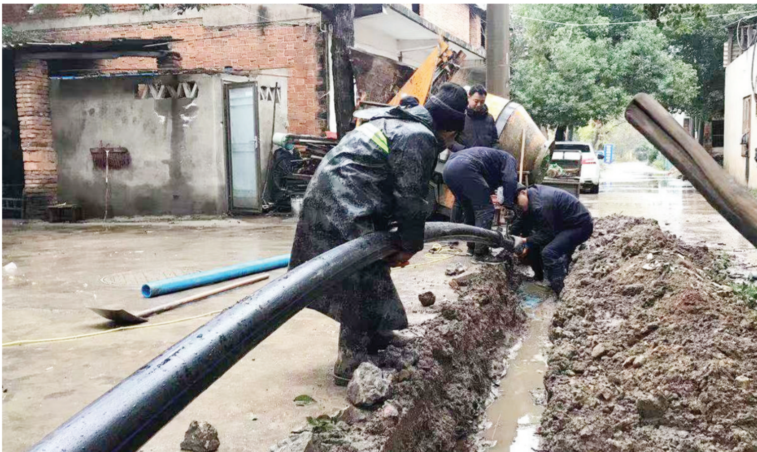
11月25日,广水市第一自来水公司冒雨施工,抢通应办双桥社区供水管道。(随州日报通讯员黄萍、郝贤政摄)
