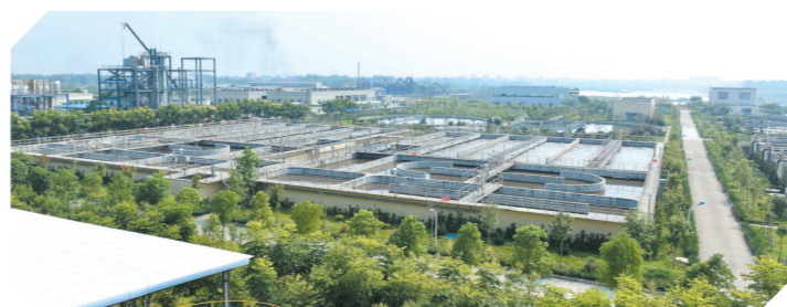
▲ 随州市污水处理厂
