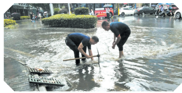
▲ 雨中巡查排污管网畅通
