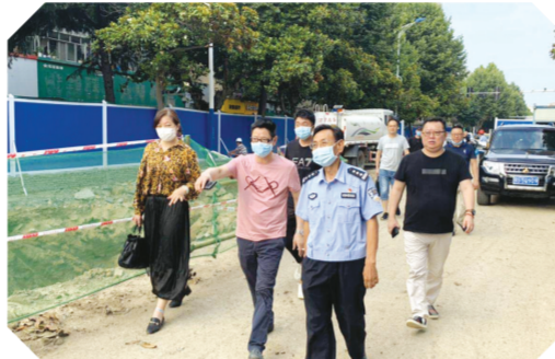
▲ 和交警一起查看汉东路改造封路施工情况
