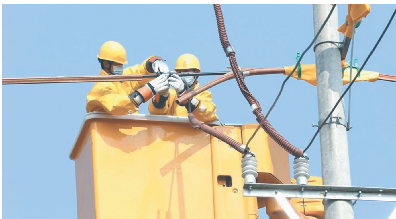
12月8日,从广水市供电公司获悉,陈巷镇雷家10千伏线路带电搭火改造工程圆满完成。据悉,该市已全面梳理2020年农网改造工程中符合带电搭火作业的施工现场,将坚持“能带不停”原则,继续加强多部门间沟通协作,减少停电作业对正常供电的影响,当好“电保姆”。(随州日报讯通讯员黄萍、李倩摄)
