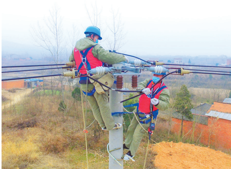
▲1月5日,曾都区供电公司充分利用10千伏万镇线万60线路的停电机会,组织5个供电所施工人员同步开展线路自动化改造、三冬检修除缺、网改施工、线路投运、负荷改接、基础运维树障清理六项工作任务,用最短的时间和最快的速度,保质保量完成各项工作任务。(随州日报通讯员 何厚锦 晏家琪摄)
