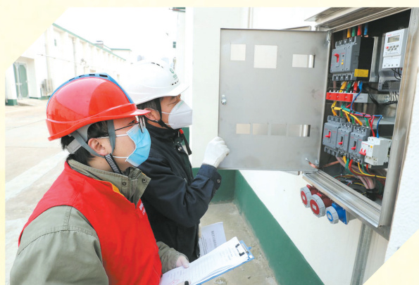
▲ 国网随州供电公司工作人员帮助企业检查计量设备
