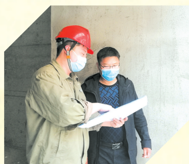
▲ 国网随州供电公司工作人员到碧桂园查看电表工程
