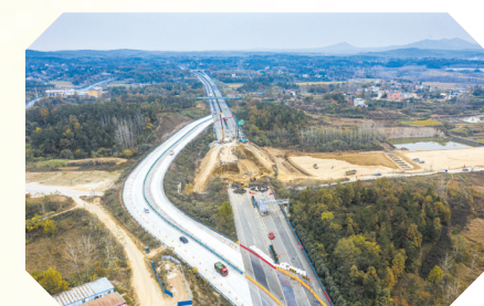
▲ 浪河至何店一级公路下穿麻竹高速建设现场
