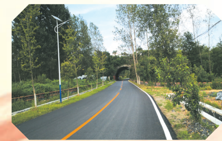
▲ S327洛府线标线施工
