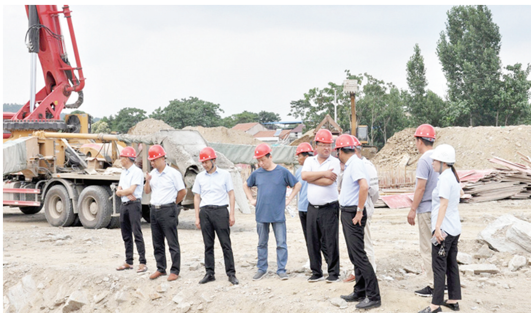
近日,广水市供水办开展安全生产大排查活动,对该市第一自来水公司进行安全生产大检查,对排查出的问题立即整改,确保安全生产。图为该市供水办到供水公司3万吨水厂扩建工程工地进行安全检查。(随州日报特约记者程琪、通讯员郝贤祺)
