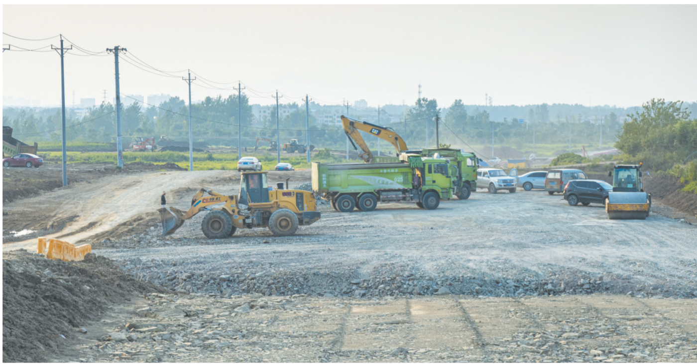
为缓解交通压力,支持和配合青春化工园建设,新316国道浙河段扩建工程目前正在加快推进中,跨麻竹高速大桥和穿路管涵已进入全面施工阶段。图为位于青春化工园路段路基填筑现场。(随州日报全媒体记者李文军摄)
