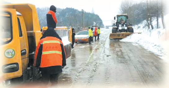
▲ 公路养护、路政人员上路撒盐除雪保畅通
