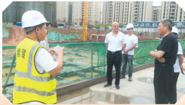
▲ 人防工程安全检查
