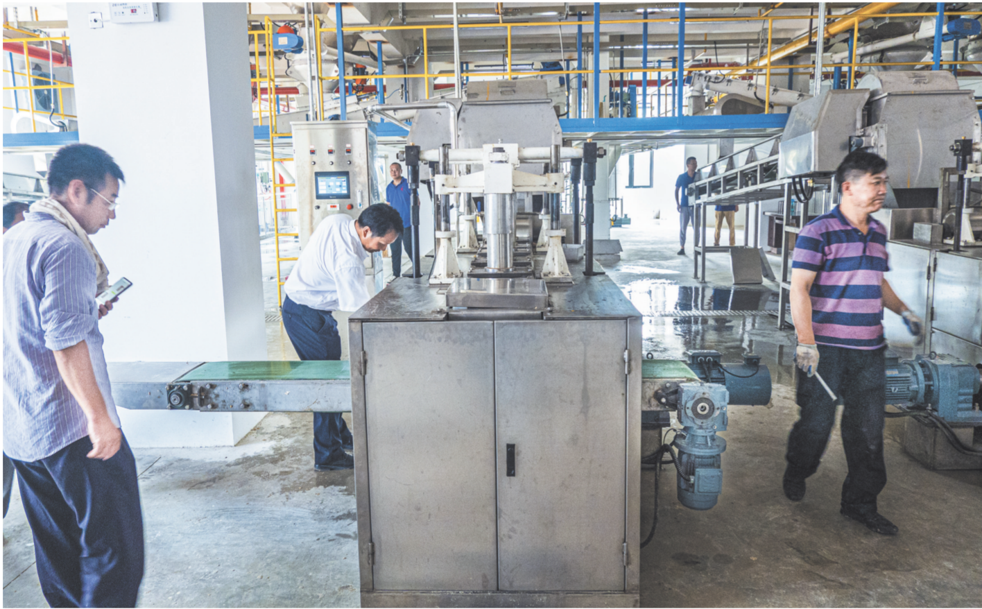
黄鹄楼酒业随州搬迁扩能项目稳步推进,整个项目分三期建设,项目一期主体工程已经完工。三期项目全部建成后,将达到年产3万吨基酒、年创利税超亿元的目标。目前技术人员正在进行设备安装调试。(随州日报全媒记者李文军摄)
