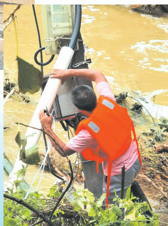
▲ 抢险队员抢修恢复基站电力
