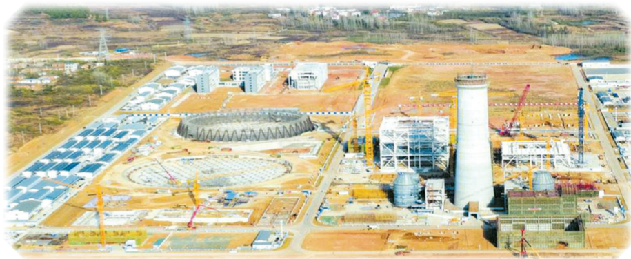
▲ 建设中的随州电厂项目
