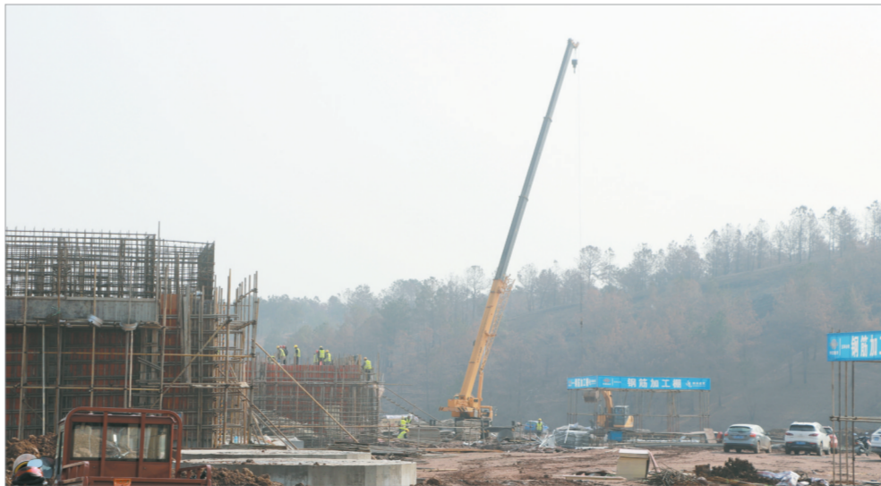
近年来,广水市坚持凝心聚力“大抓项目、抓大项目”,一批工业、技改、城建等重大项目建设加快推进。图为广水市精细化工园项目施工现场。该项目总投资8.02亿元,用地2100余亩。(随州日报全媒体记者陈云摄)
