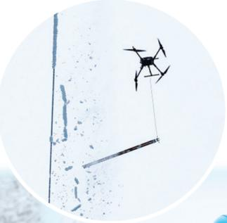
在操作员的操作下,无人机挂载着适量的绝缘操作杆升空,调整好高度后,无人机携带着绝缘操作杆撞向电线,电线上面的覆冰快速掉落。
