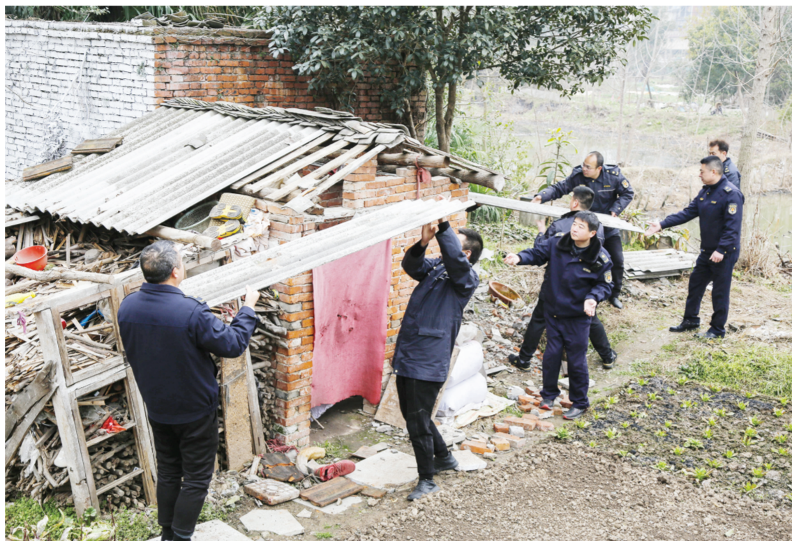
攻克创卫工作难点,消灭环境卫生“盲区”。连日来,市城管执法委出动执法管理人员,协助曾都区各街道和社区(村组),对散布在城乡结合部和偏僻位置的卫生死角进行清理,共计拆除房前屋后、田间地头、隐蔽角落等点位的简易厕所、看护房、杂物间近100处,有效改善了城乡人居环境。图为执法人员正在拆除白云社区公园小区的简易厕所。(随州日报通讯员 袁少峰摄)
