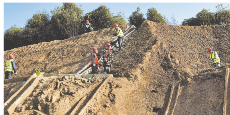
随州南外环全线建成通车后,目前正在加紧进行道路绿化、美化、亮化工程建设。图为工人们正忙着在南外环东大街大道段进行边坡绿化景观施工。(随州日报全媒体记者李文军摄)
