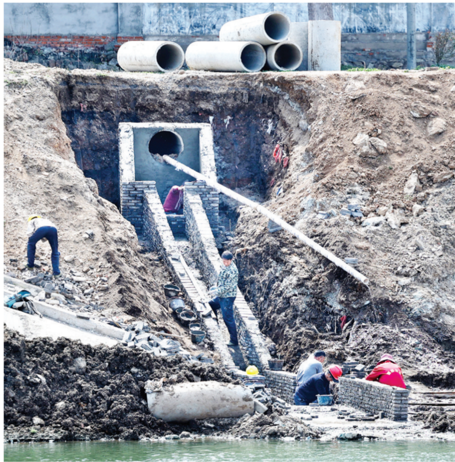
近年来,随县大力推进城镇地下管网改造,实施城镇排水防涝能力提升工程,深入推进城镇生命线安全工程建设,增强防洪排涝能力和基础设施承载力,不断提升群众生活舒适度、便利度,改善城镇人居环境。图为潭潭镇区雨污分流排水管网改造项目施工现场,工人们正在进行开挖涵管作业。(随州日报全媒体记者李文军摄)
