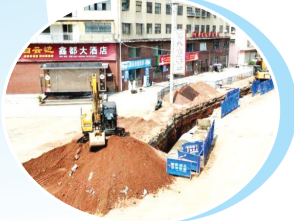
朝阳街防洪排涝工程施工现场
