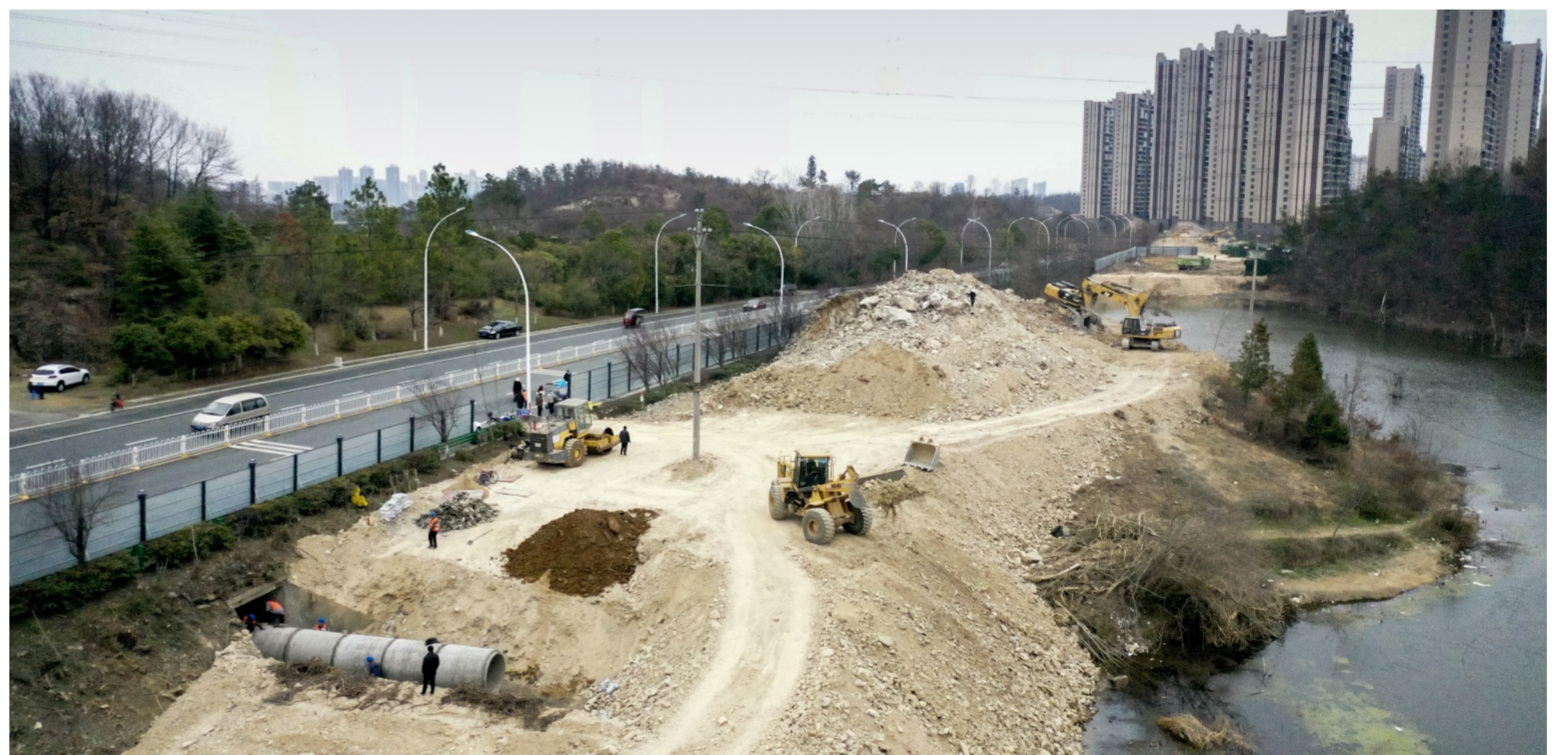
近日,我市迎宾大道改造提升工程全面启动,迎宾大道两侧将建设慢行系统,梳理两侧非机动车道、沿线公交站点、配套设施提升,同时对何店高速出入口节点、麻安高速高架桥节点及高铁下穿桥梁节点提升改造等。(随州日报全媒体记者李文军摄)
