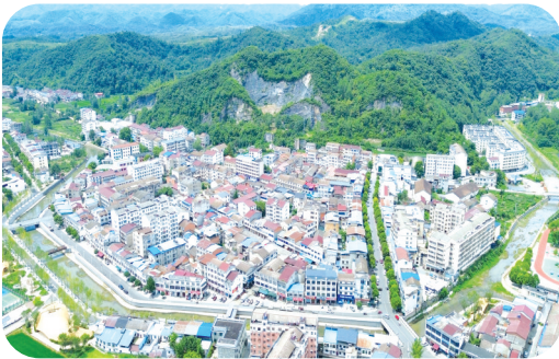
▲ 洛阳镇清水河系统治理工程
