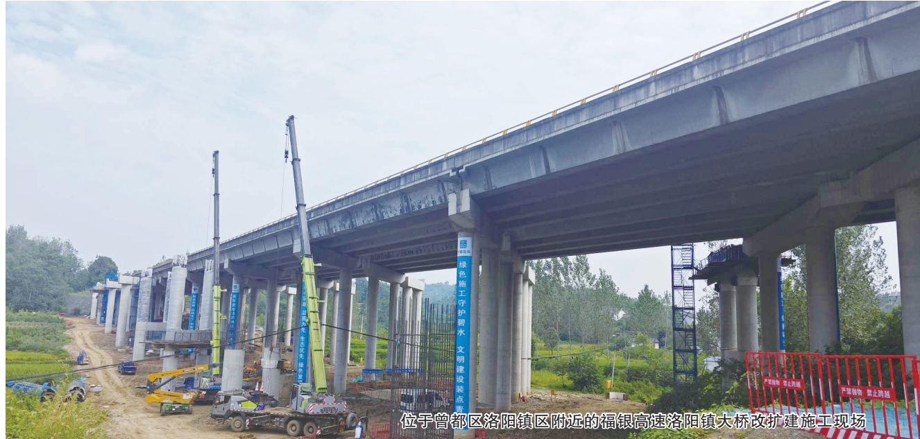
位于曾都区洛阳镇区附近的福银高速洛阳镇大桥改扩建施工现场
